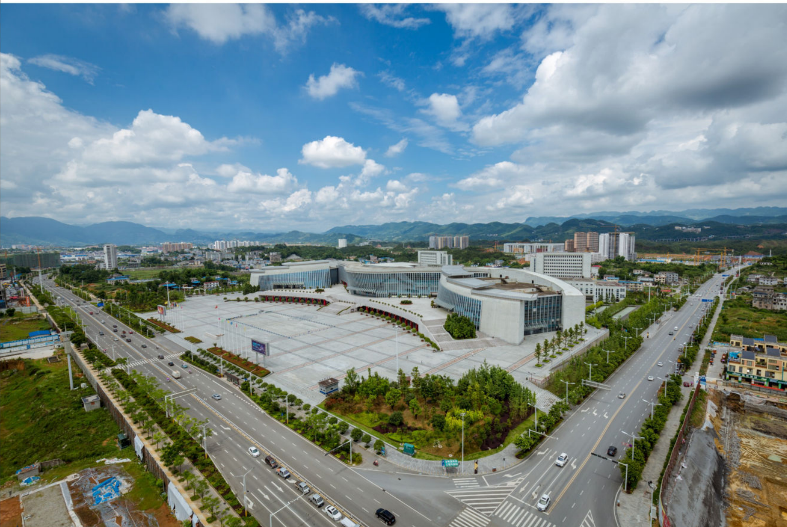
恩施州文化中心全貌（武 宏/摄）
