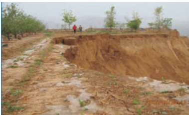
永靖盐锅峡滑坡后壁
