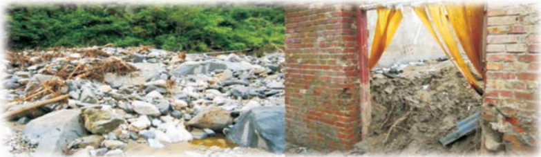
泥石流堵塞河道并冲入房屋(成县)
