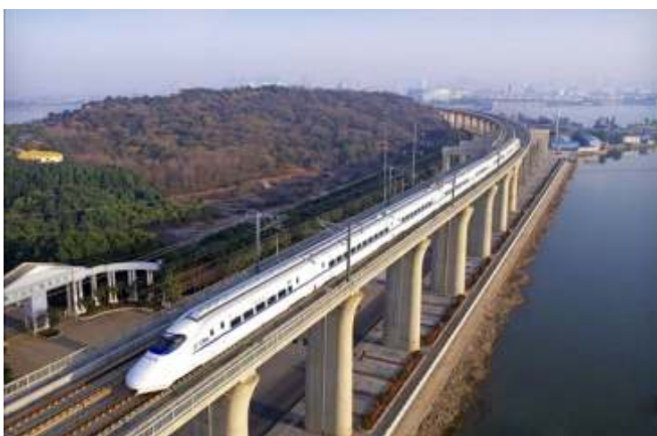
武咸城际铁路
