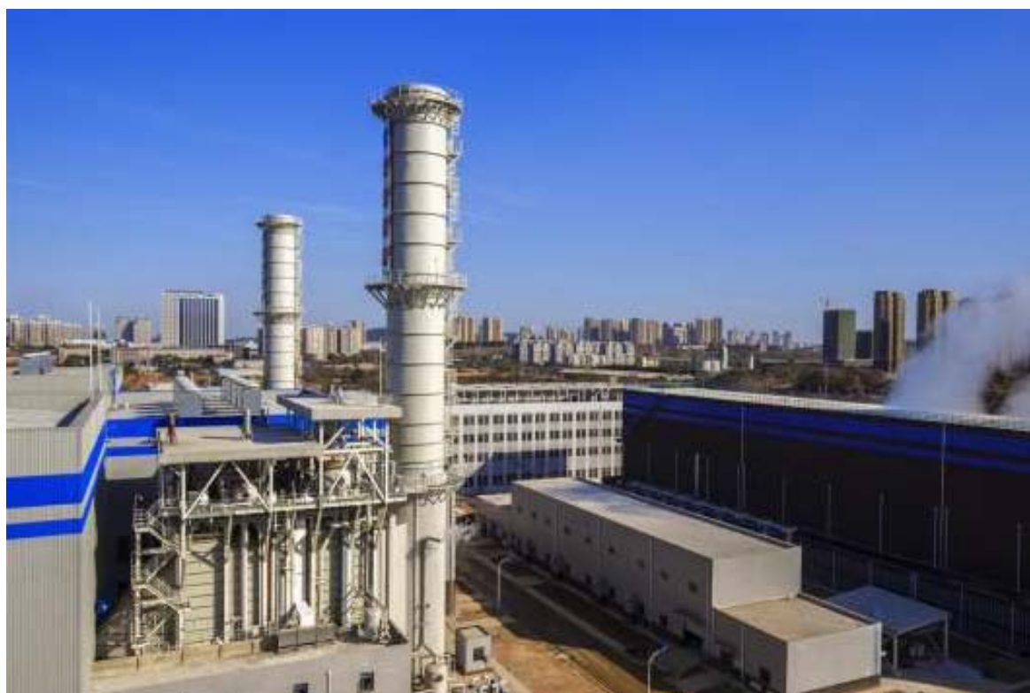
东湖燃机热电联产工程（ 2 \times 18.5 万千瓦）1号机组投产发电
