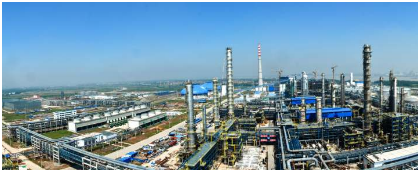
武汉80万吨乙烯工程
