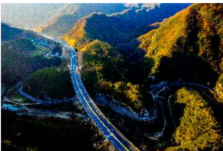
十房高速公路
