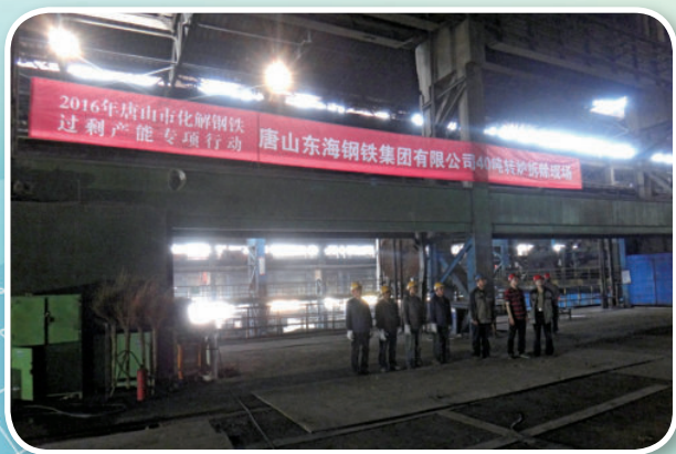
2016年6月，滦县组织拆除唐山东海钢铁有限公司40吨转炉1座
