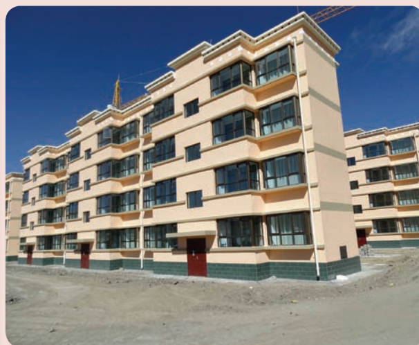
2015年公租房项目投入使用
