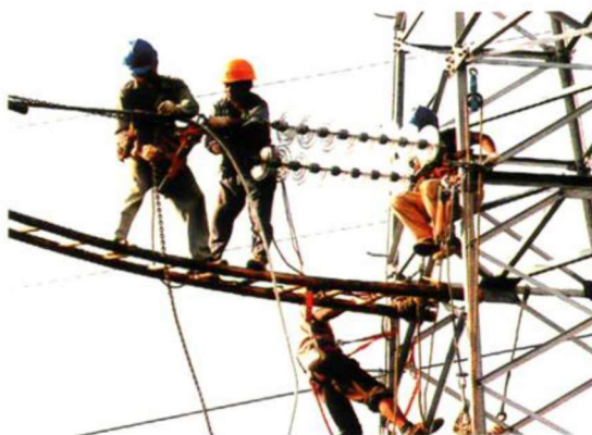
10千伏电网改造架线
