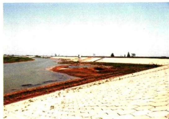
芜湖江堤麻风圩加固工程完工
