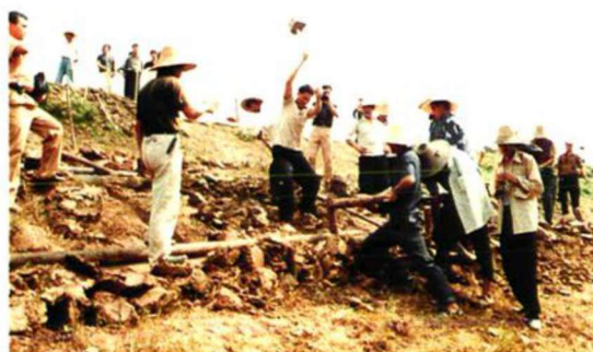
联建圩抢险堵漏
