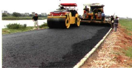
建设中的芜当江堤万春圩段加固工程
