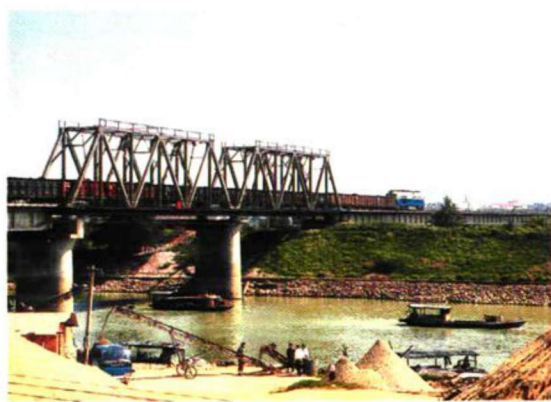
皖赣铁路复线湾沚青弋江大桥
