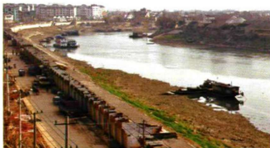
县城湾沚镇防洪墙
