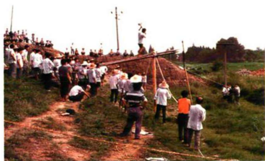
新连圩抗洪打桩
