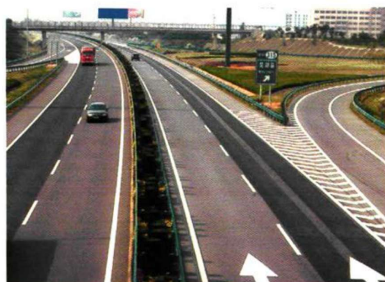
芜宣高速公路县城出入口
