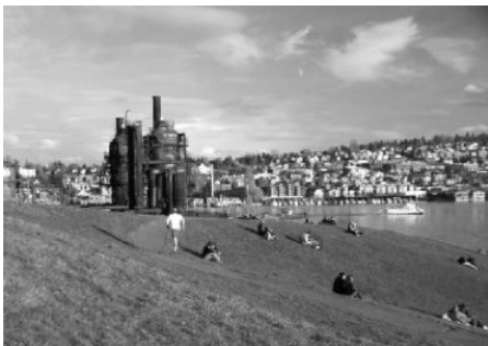
图 1.1 改造后的西雅图煤气厂
