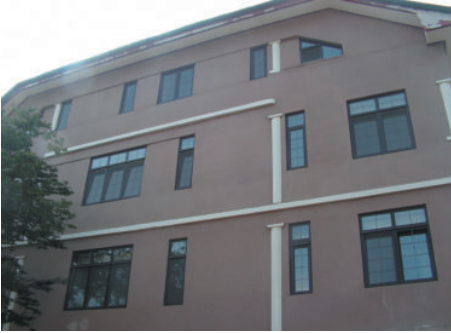
彩图 19 45 年前北九水疗养院病房楼外观已被改建，有些可惜
