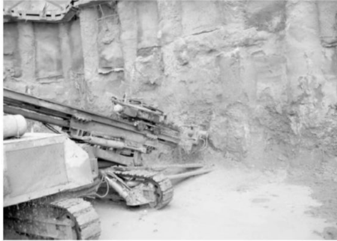
图 1-4 套管跟进锚杆施工
