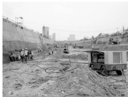
图 1—3 预应力锚杆复合土钉墙
