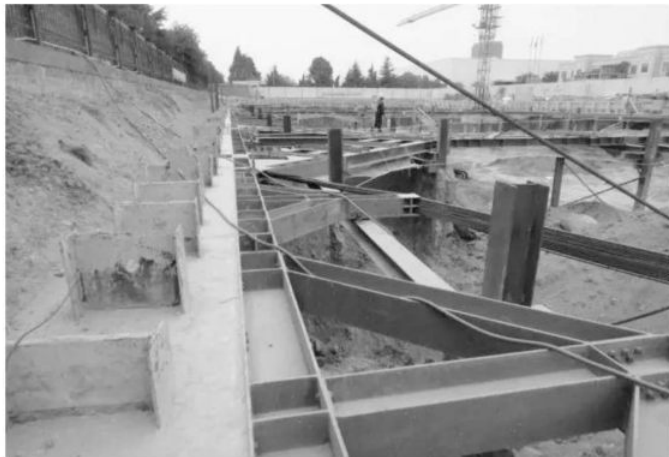
图 1-6 工具式钢结构组合内支撑
