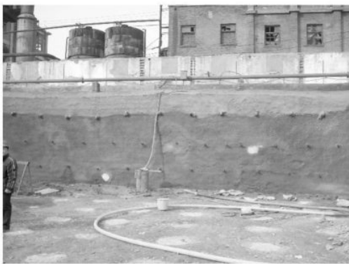
图 1—2 截水帷幕复合土钉墙
