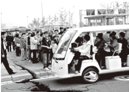
图 1-4 地面下沉开裂
