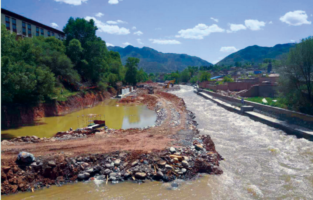
隆务河流域河道治理工程 马成英/提供
