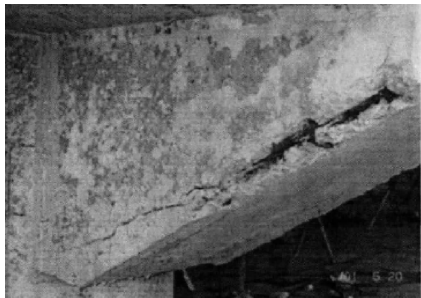
图 1.6 桥系梁开裂
