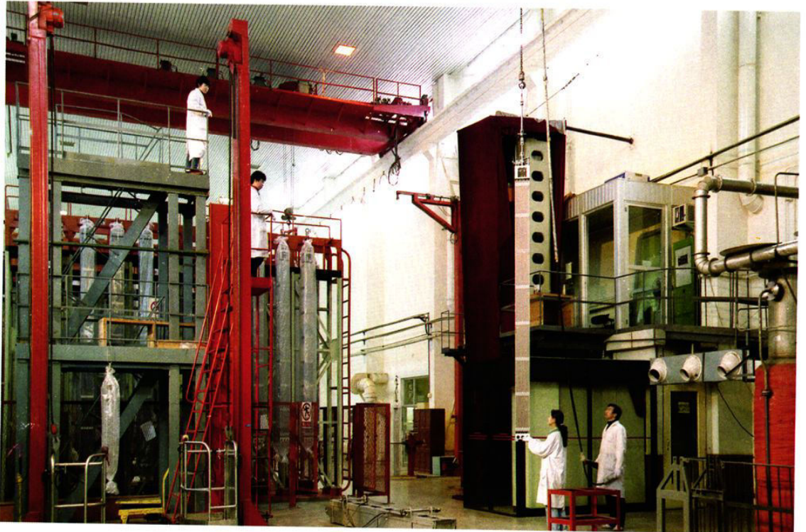
中核建中核燃料有限公司核燃料组装车间
