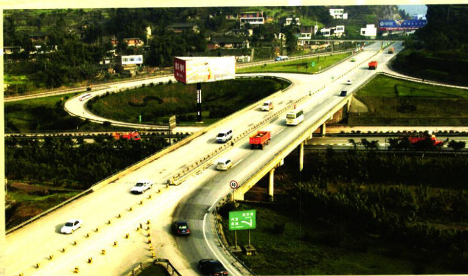
内宜高速宜宾南立交桥
