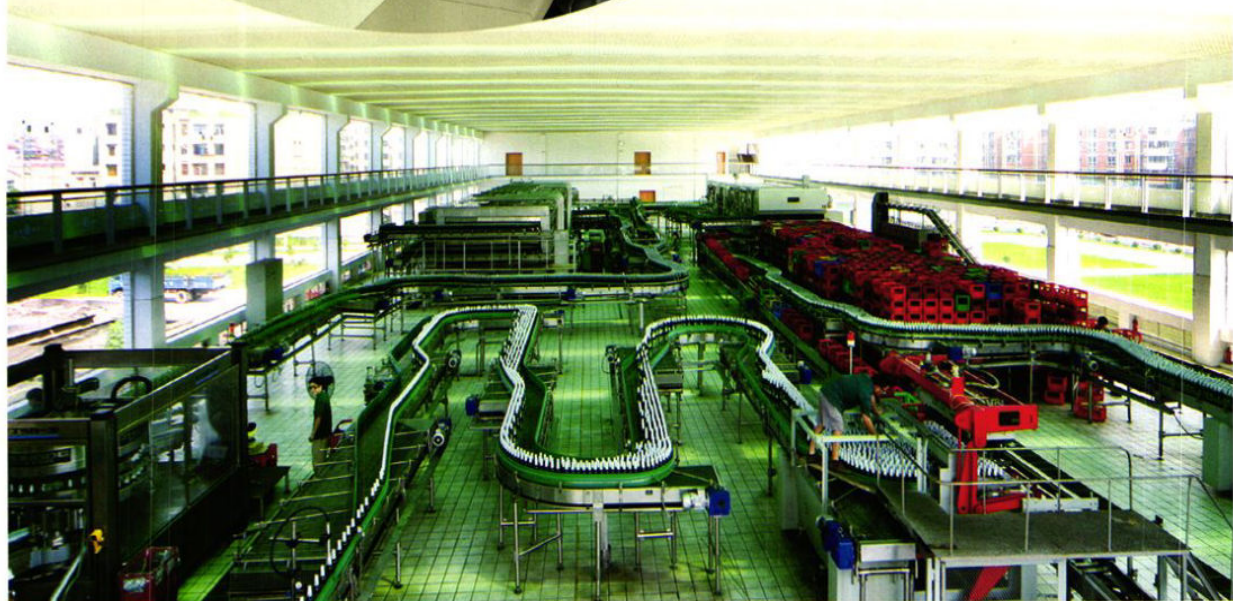
重庆啤酒集团宜宾啤酒有限公司罐装车间
