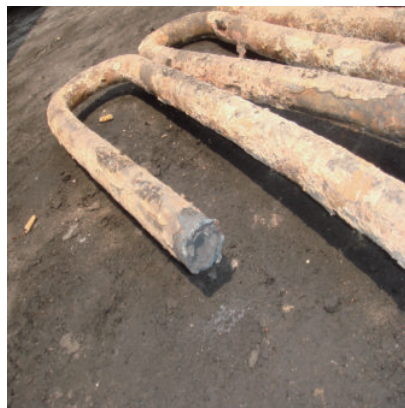
图 1-2 郴州有机热载体炉事故积炭管
