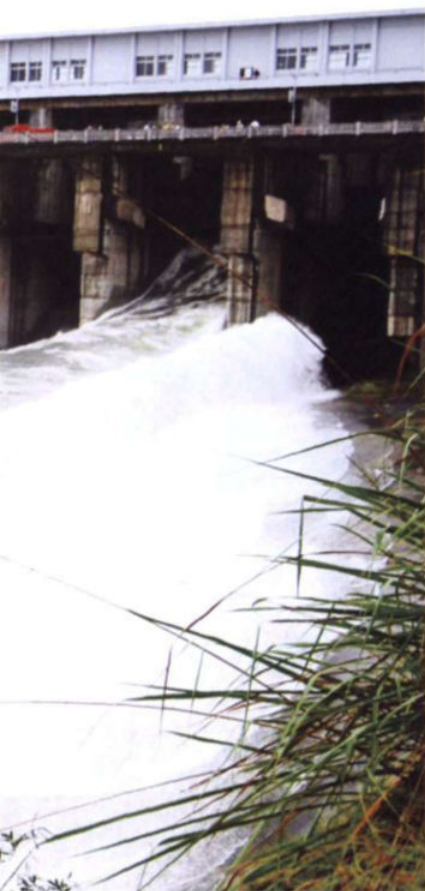
升钟水库溢洪道
