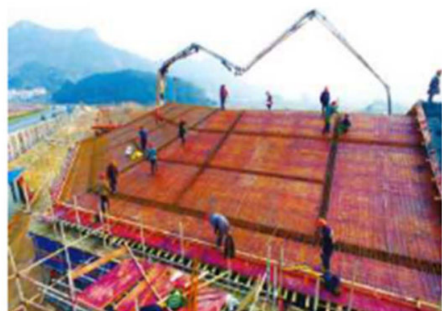
石城县游客集散中心施工现场
