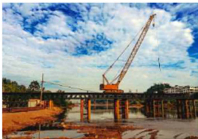
兴泉铁路石城段琴江特大桥施工现场 温礼明 摄
