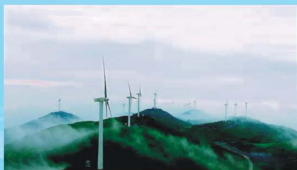
齐岳山风电三期工程建设
