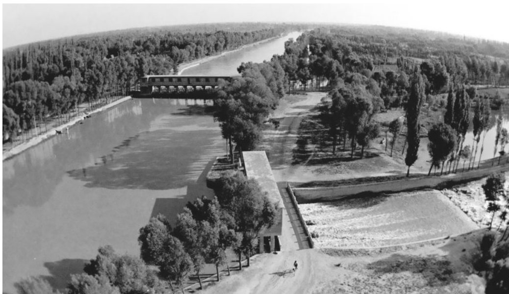
改建整修的惠农渠龙门桥水闸 新华社记者 陈思禹 / 摄 (1988 年 9 月 13 日发)
