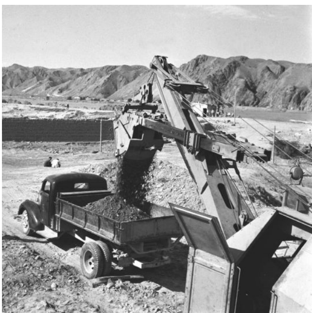
青铜峡水库工程正在积极施工 新华社记者 王新著 刘勋华 / 摄( 1958 年 10 月 15 日发 )
