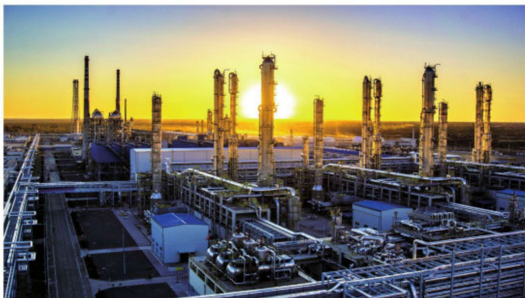
未来能源煤制油项目装置区
