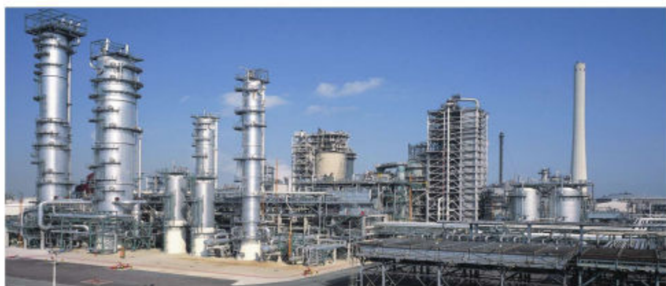
延长集团50万吨/年煤油混炼项目
