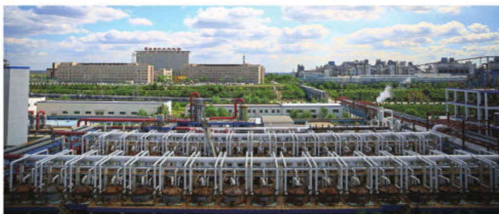
陕西煤化北元化工100万吨聚氯乙烯项目
