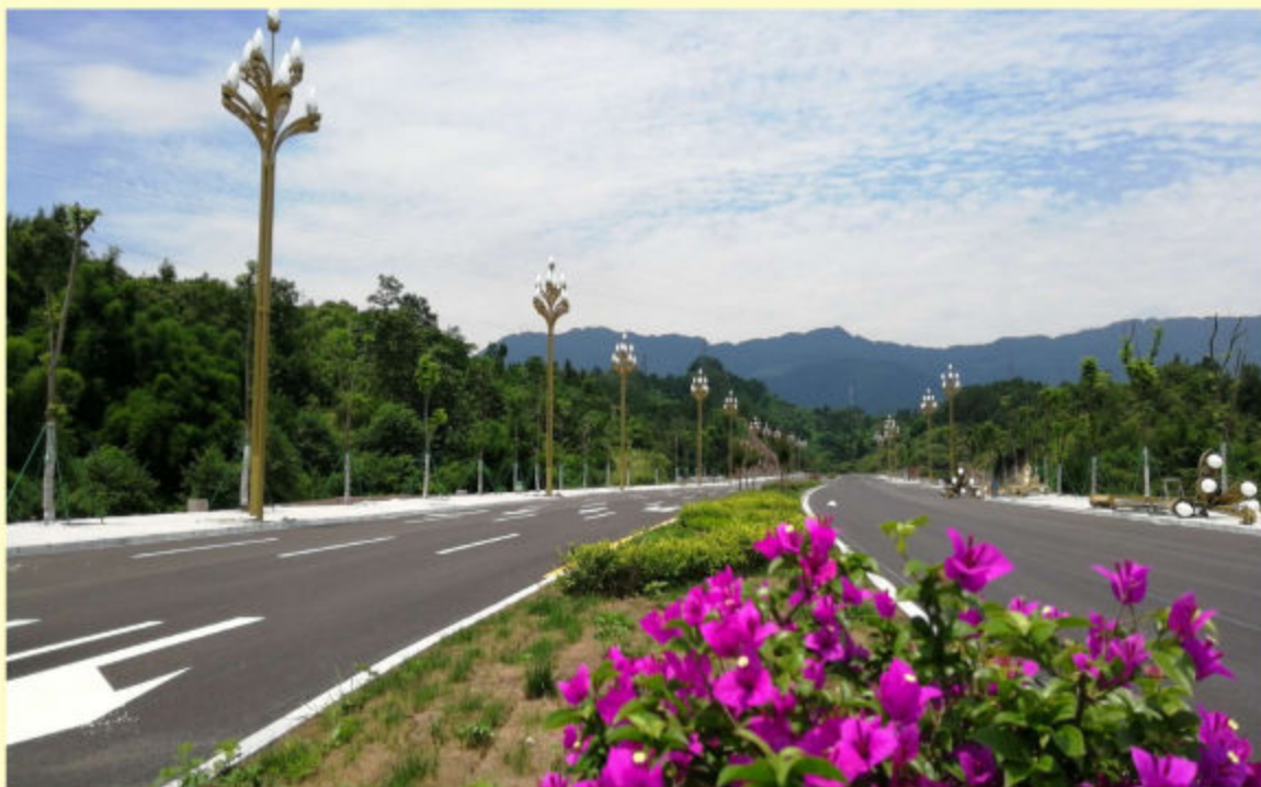
金南大道西延线三期东段
