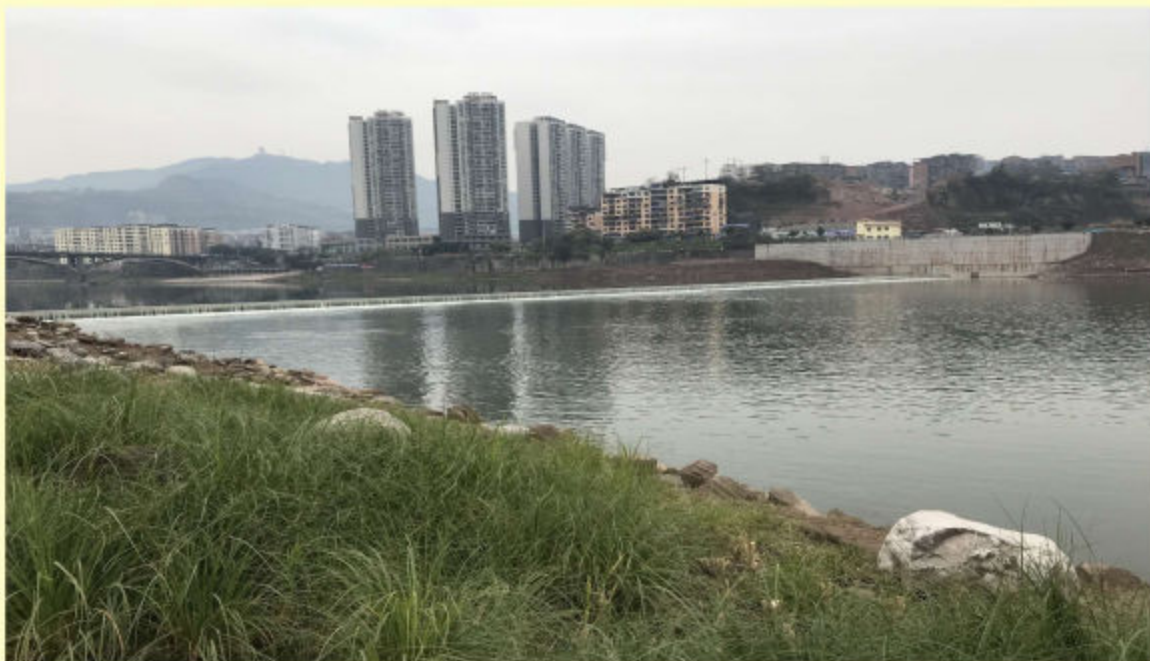
2017年12月，塔垵州河液压升降坝工程竣工，进行蓄水试运行
