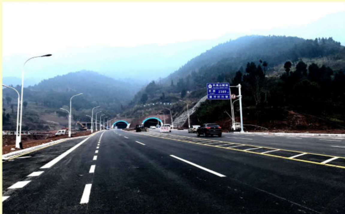
2017年12月30日，凤凰山隧道建成并投入使用
