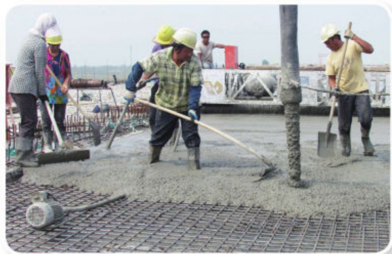
曲港高速桥建设施工
