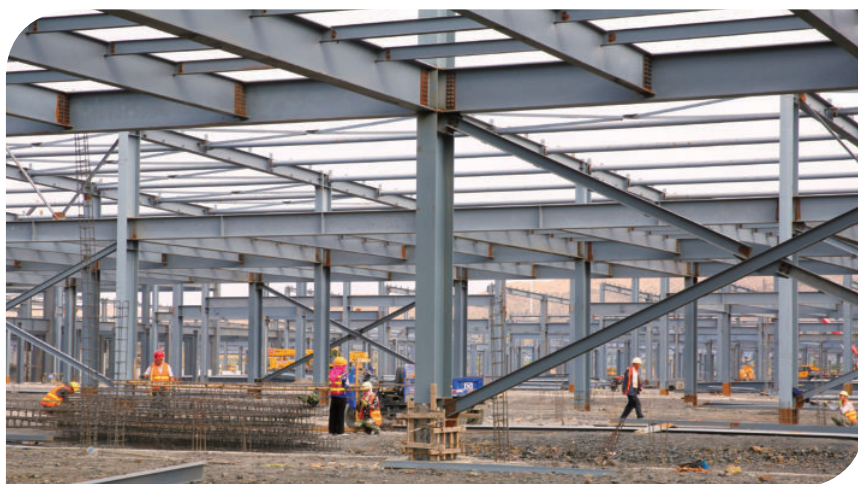
美利云数据中心二期项目
