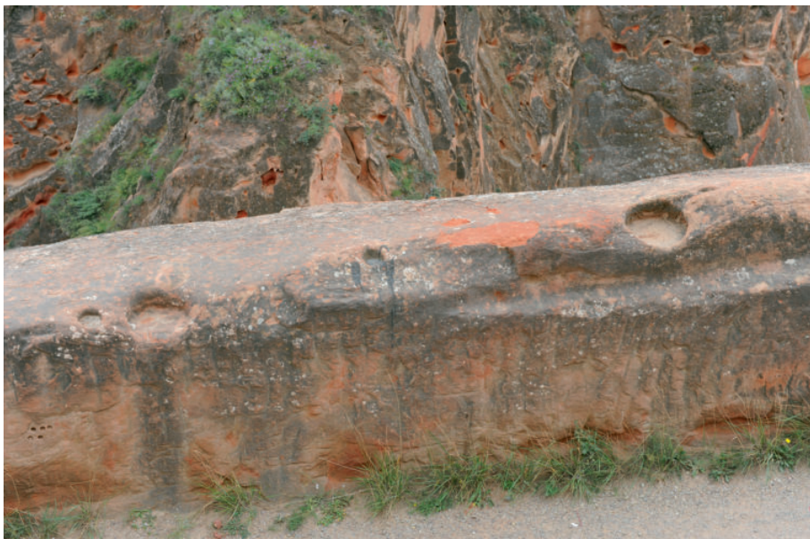
固定木栏杆的石窝（摄影时间同前）
