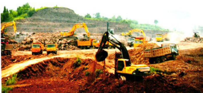
园区基础设施建设加快推进
