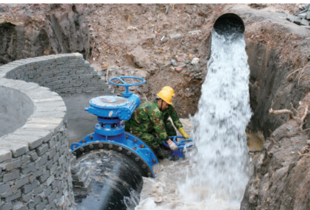
确保民生——2014年5月29日，河东水厂第二条出水管建成试通水成功
