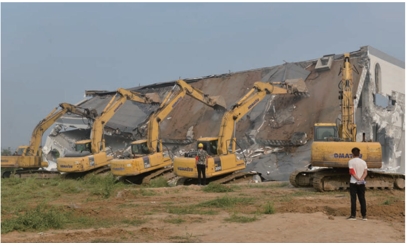
9月，清苑区开展拆除白洋淀大道两侧违法建筑集中行动 许明昭 摄
