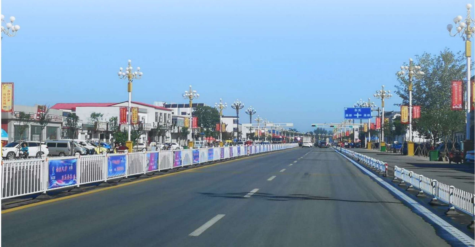
2018 年 9 月，国道 104 线吴桥县城区段（县交通局提供）
