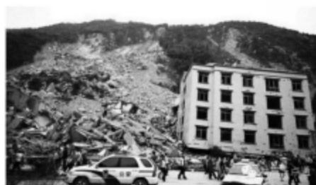
图 1-2 地震引发的山体崩塌
