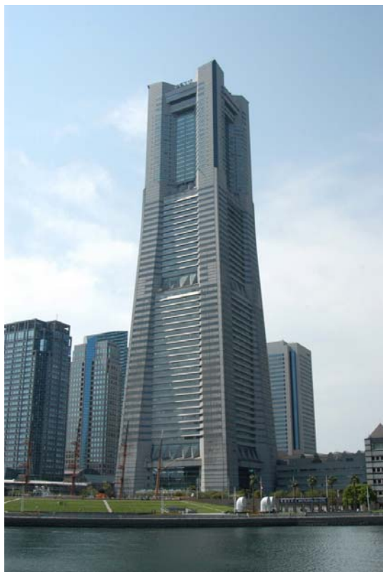
图 1.3 Landmark Tower (日本)
