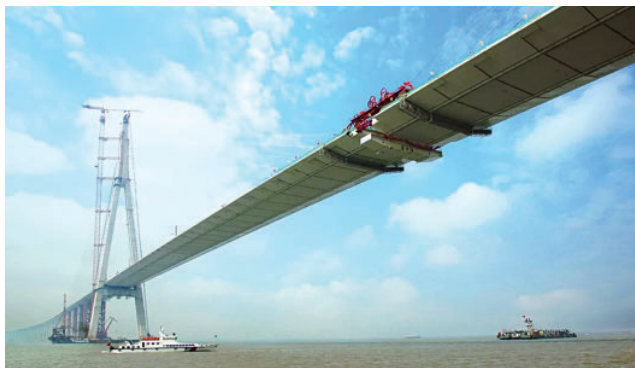
2007年6月苏通大桥箱梁中跨合龙
