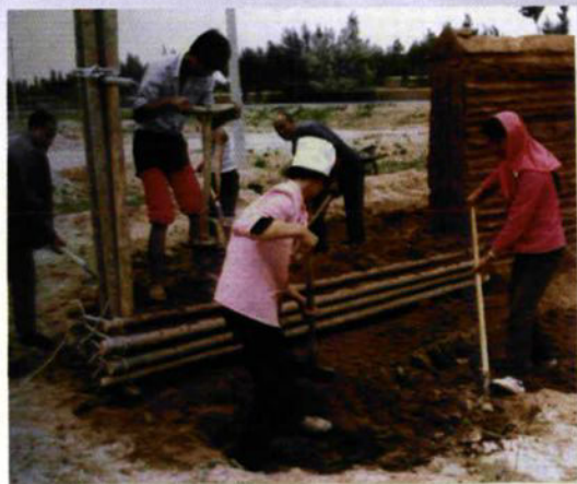
传统的板筑形式——打土墙。
