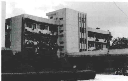
建市初期，市委、市政府办公地点——市区联检大楼（1988年）
