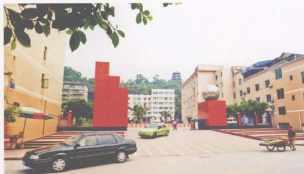
■ 区委办公大楼
