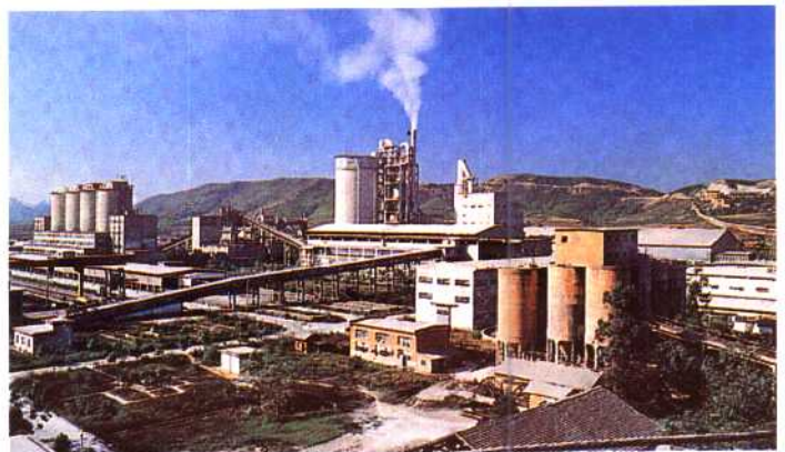
▶柳州水泥厂外景。该厂1959年引进捷克斯洛伐克设备,1964年投产,年产60万吨,经过改造达到65万吨。1982年引进丹麦干法窑外分解生产线,1986年建成。新增生产能力年106万吨。总能力年171万吨。
