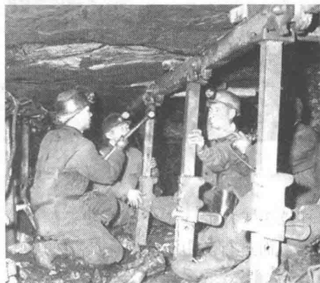
图 0-13 金属摩擦式支柱配合金属铰接顶梁支护工作面顶板
