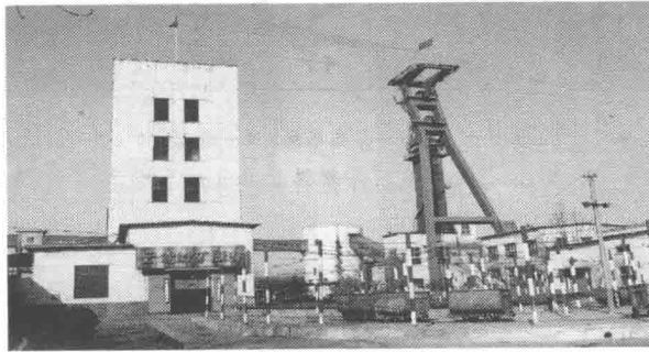
图 0-5 采用地下开采的云驾岭煤矿主副井井架
