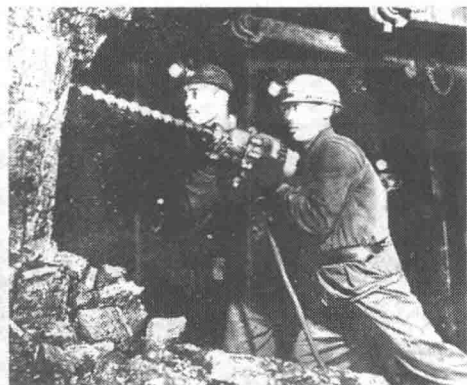
图 0-11 采煤工人用煤电钻在煤壁上钻眼
