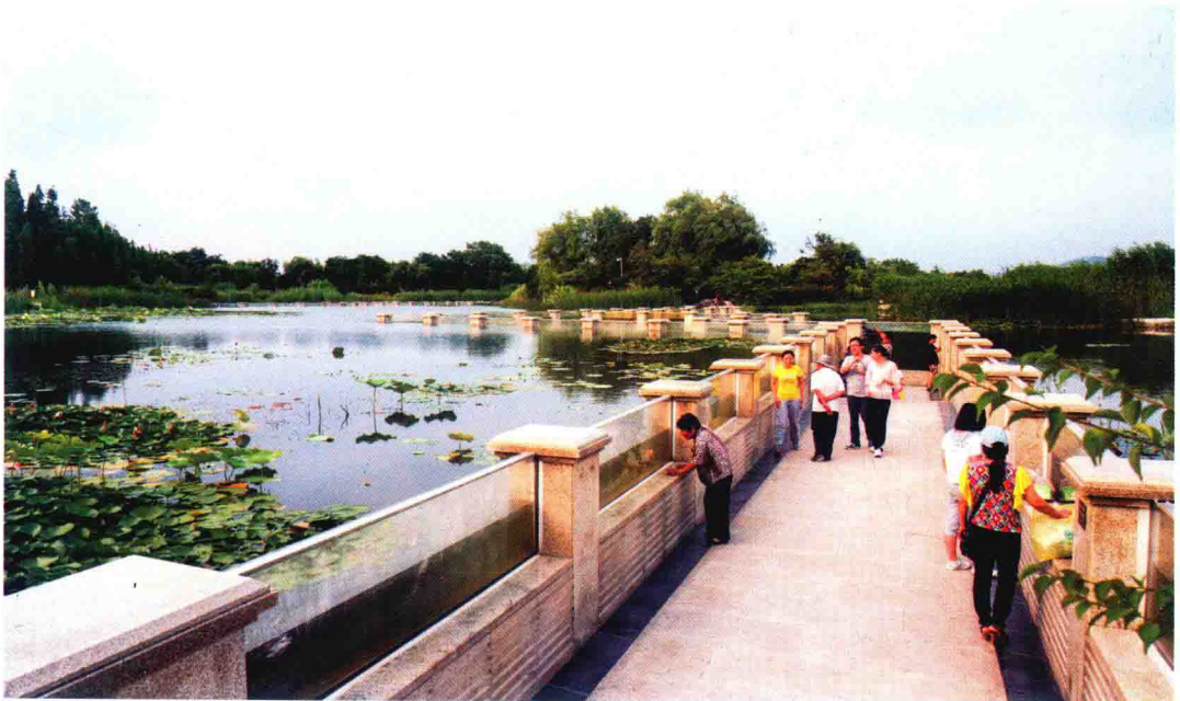
珠山景区沉水廊道
