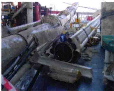
(b) 南中国海隔水管断裂事故
