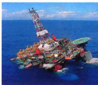
(a) 巴西P-36号浮式平台翻沉
