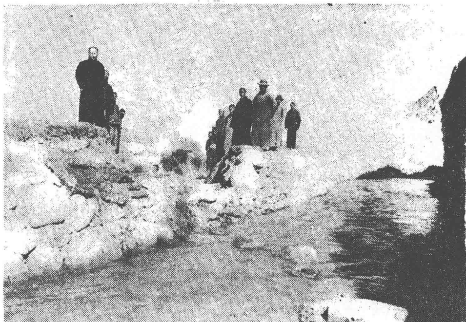
竣工理整壩頭左河渠金威武（上）
