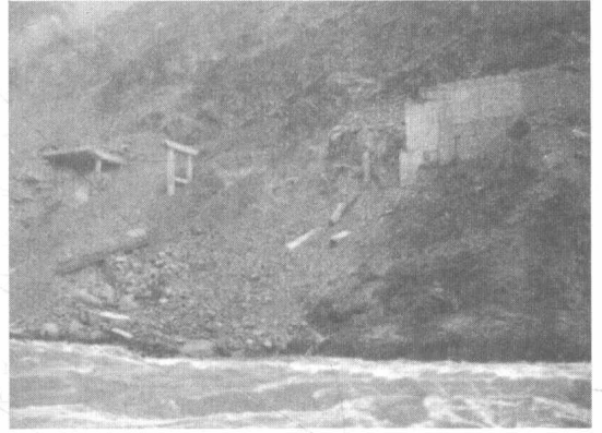
图 1-5 滑坡冲毁桥梁
