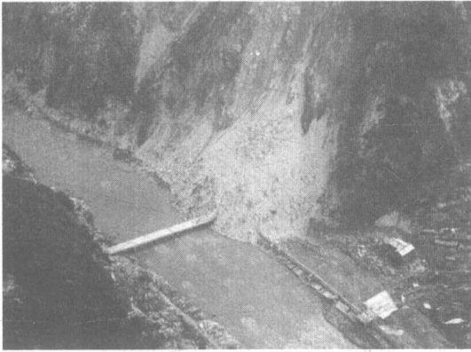
图 1-4 滑坡掩埋桥梁
