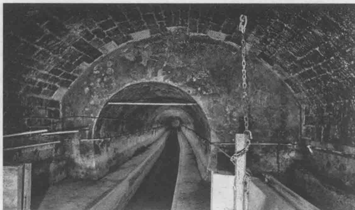
图 1-1 地下管道实景图
