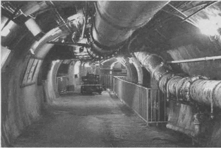
图 1-2 巴黎综合管廊
