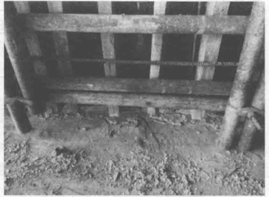
图 1-4 墙柱根部砂浆封堵实景图
