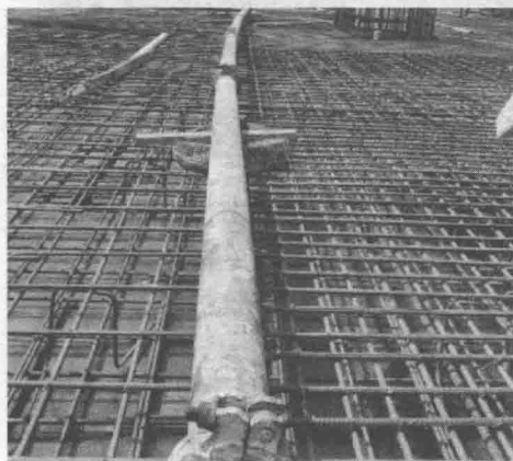
图 1-9 泵管下垫轮胎
