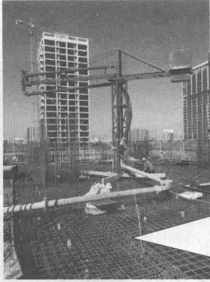
图 1-11 布料机缆风绳固定
