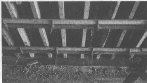
图 1-2 墙柱根部压脚板封堵
