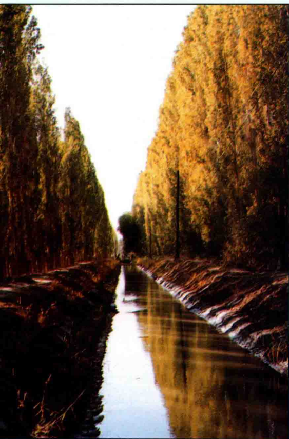
二支渠的防渗渠道和林带
