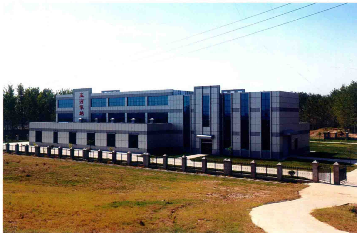
东线洪泽湖抬高蓄水位影响处理工程——安徽五河泵站
