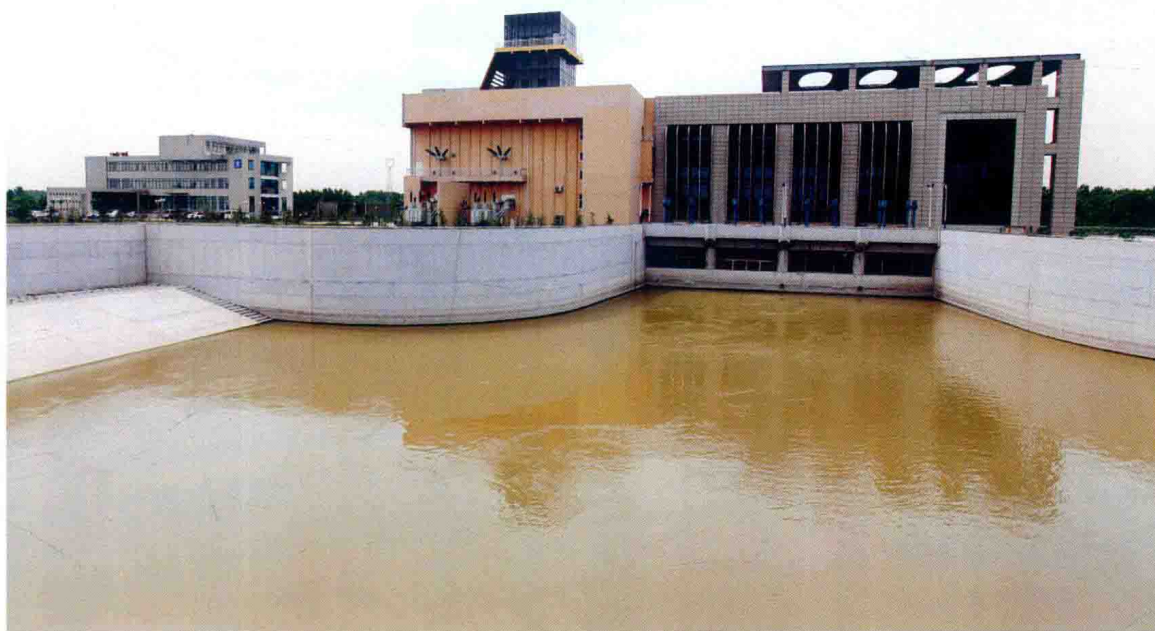
东线第十三梯级泵站——山东八里湾站
