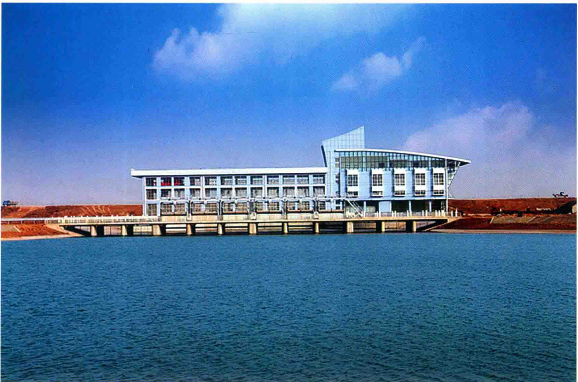
东线第九梯级泵站——江苏蒯家坝站
