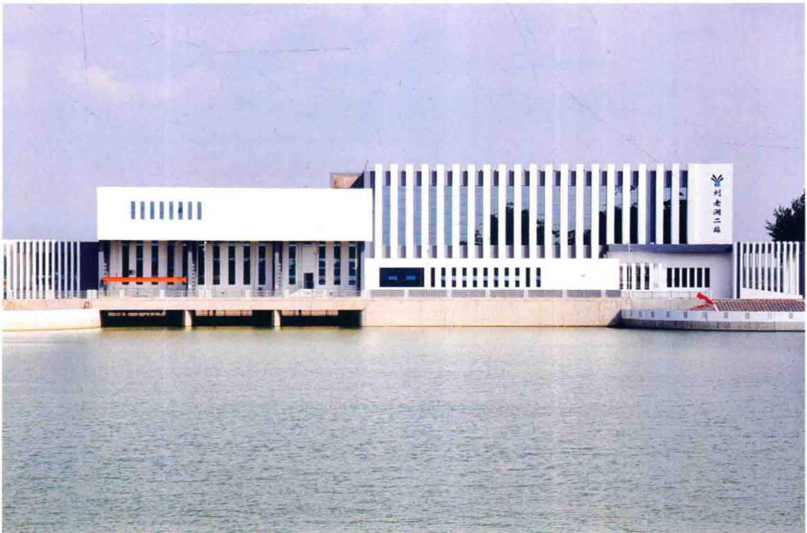
东线第五梯级泵站——江苏刘老涧二站
