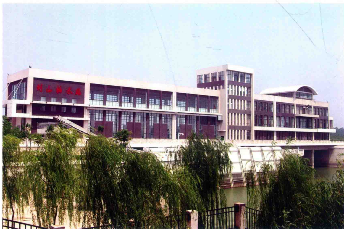
东线第七梯级泵站——江苏刘山站
