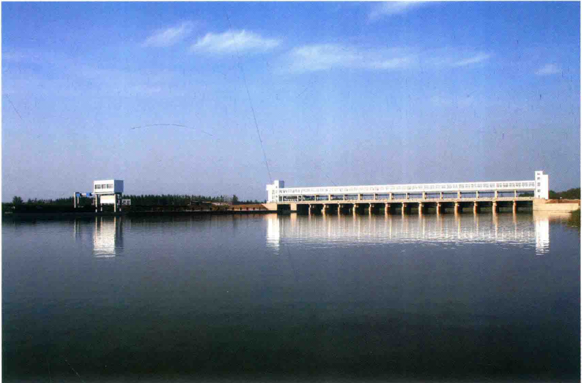
东线南四湖水资源控制工程——大沙河闸
