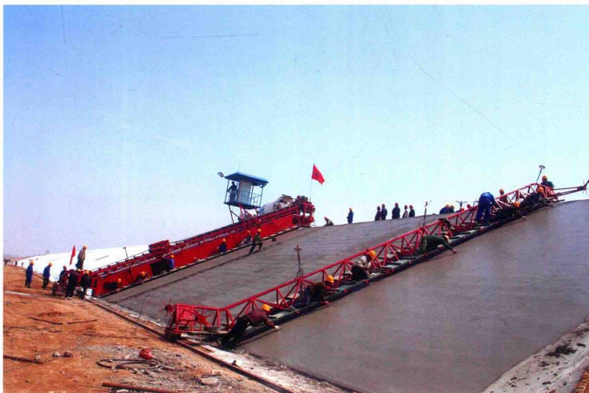
东线山东济平干渠混凝土衬砌
