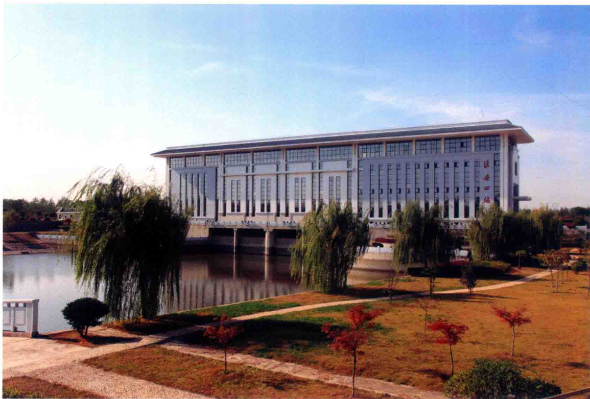
东线第二梯级泵站——江苏淮安四站
