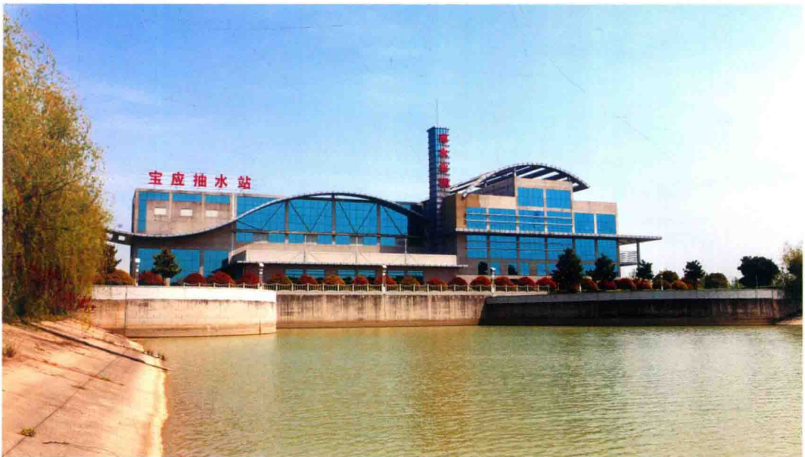
东线第一梯级泵站——江苏宝应站
