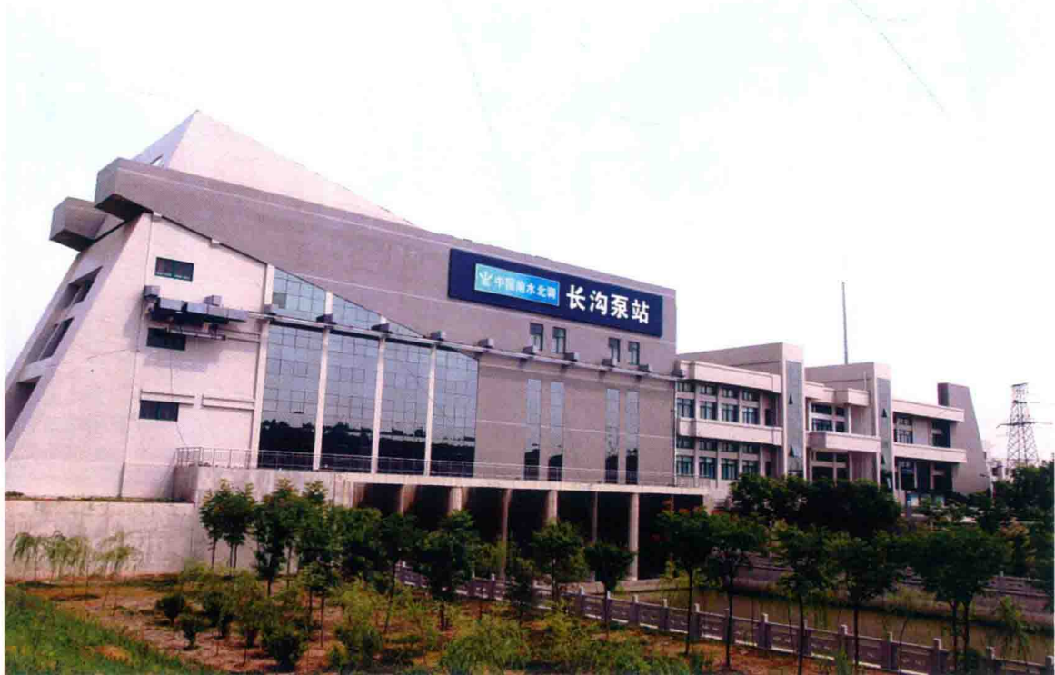
东线第十一梯级泵站——山东长沟站
