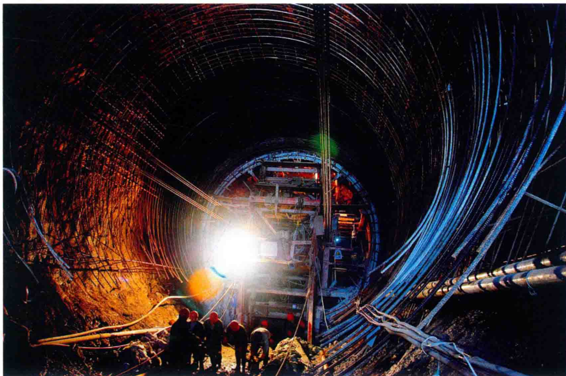
东线穿黄工程施工
