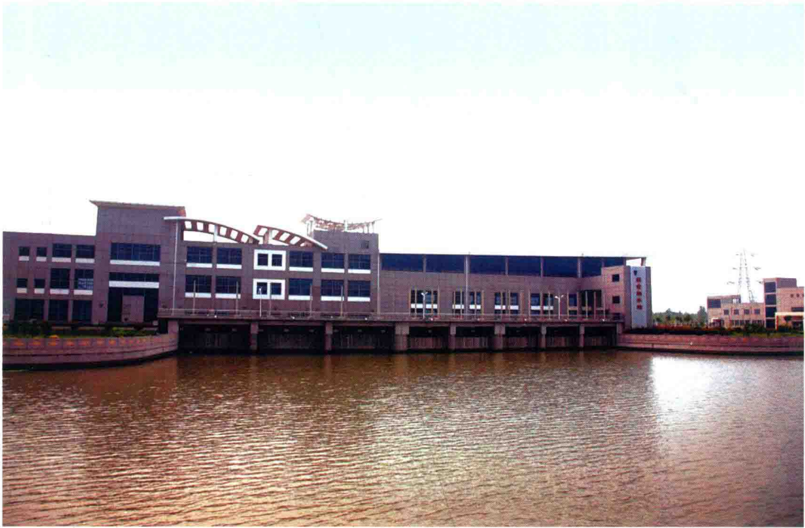
东线第八梯级泵站——江苏解台站
