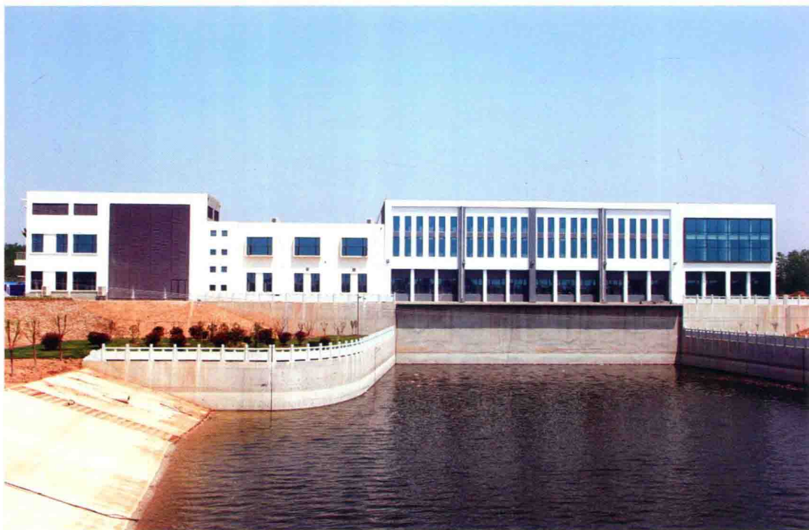
东线第六梯级泵站——江苏邳州站
