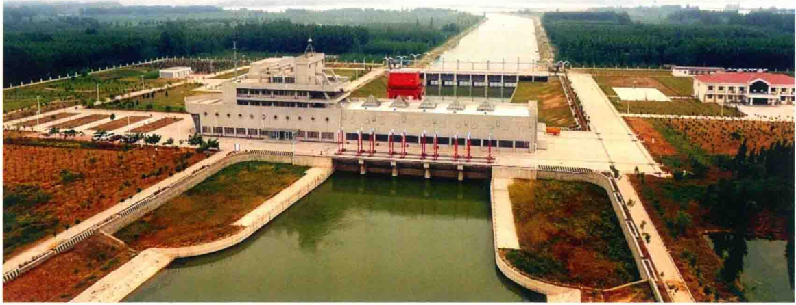
东线第十梯级泵站——山东二级坝站
