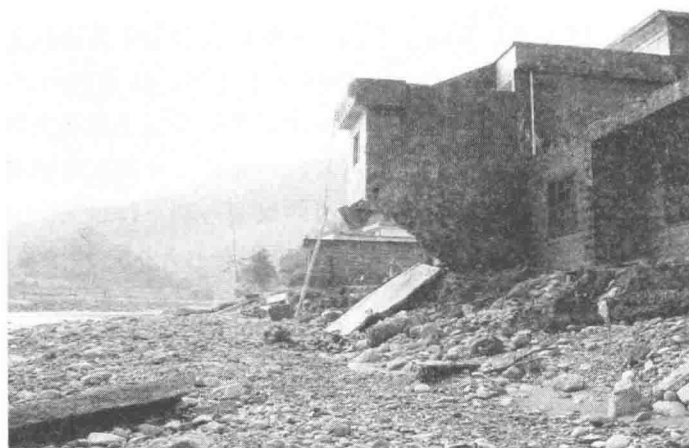
图1-1 沙兰镇房屋被洪水冲毁
