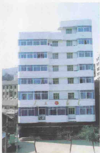
▲津洋口邮电大楼
