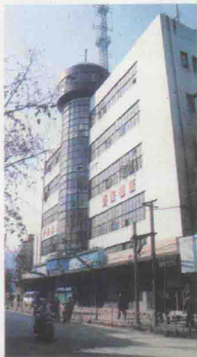
▲长阳邮电大楼
