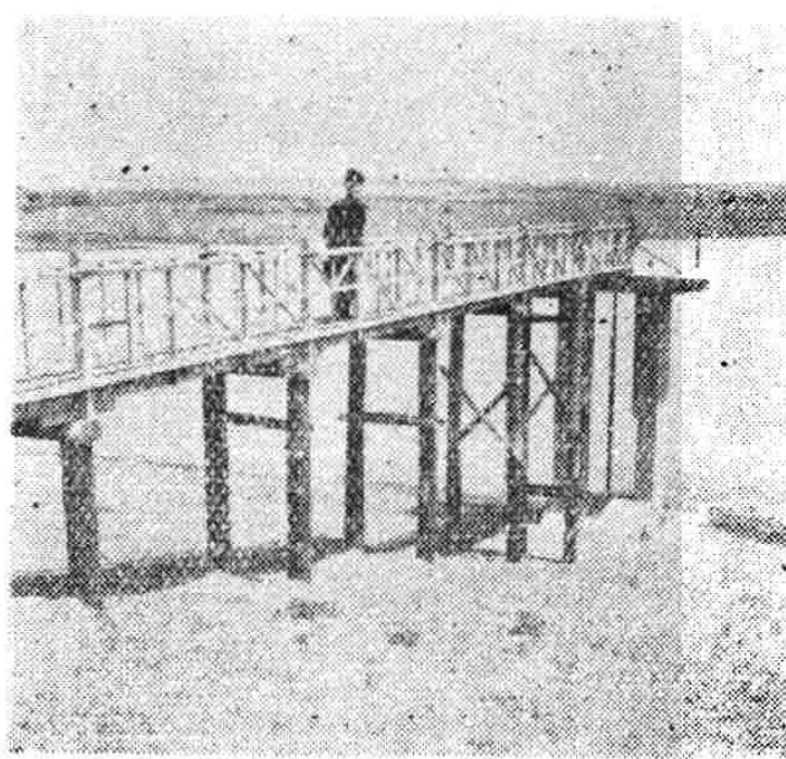
昌图县红顶山水库北输水洞 （发电洞）工作桥
