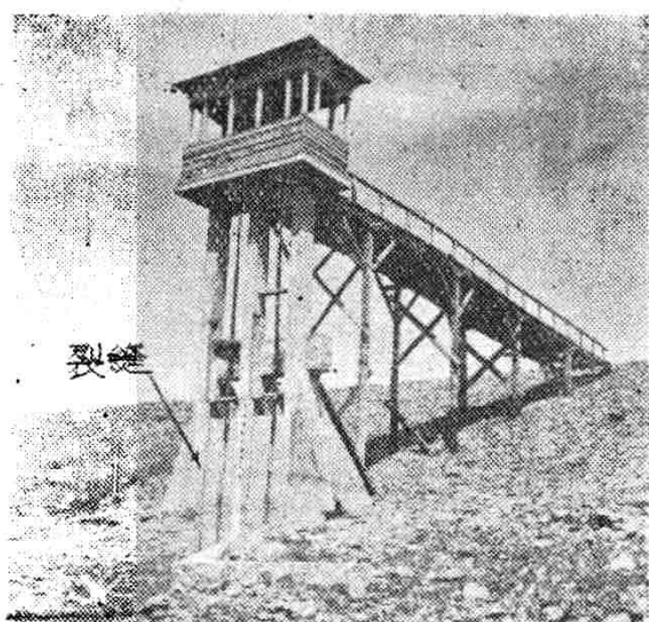
铁岭县范屯水库输水洞启闭塔及工作桥结构情况
