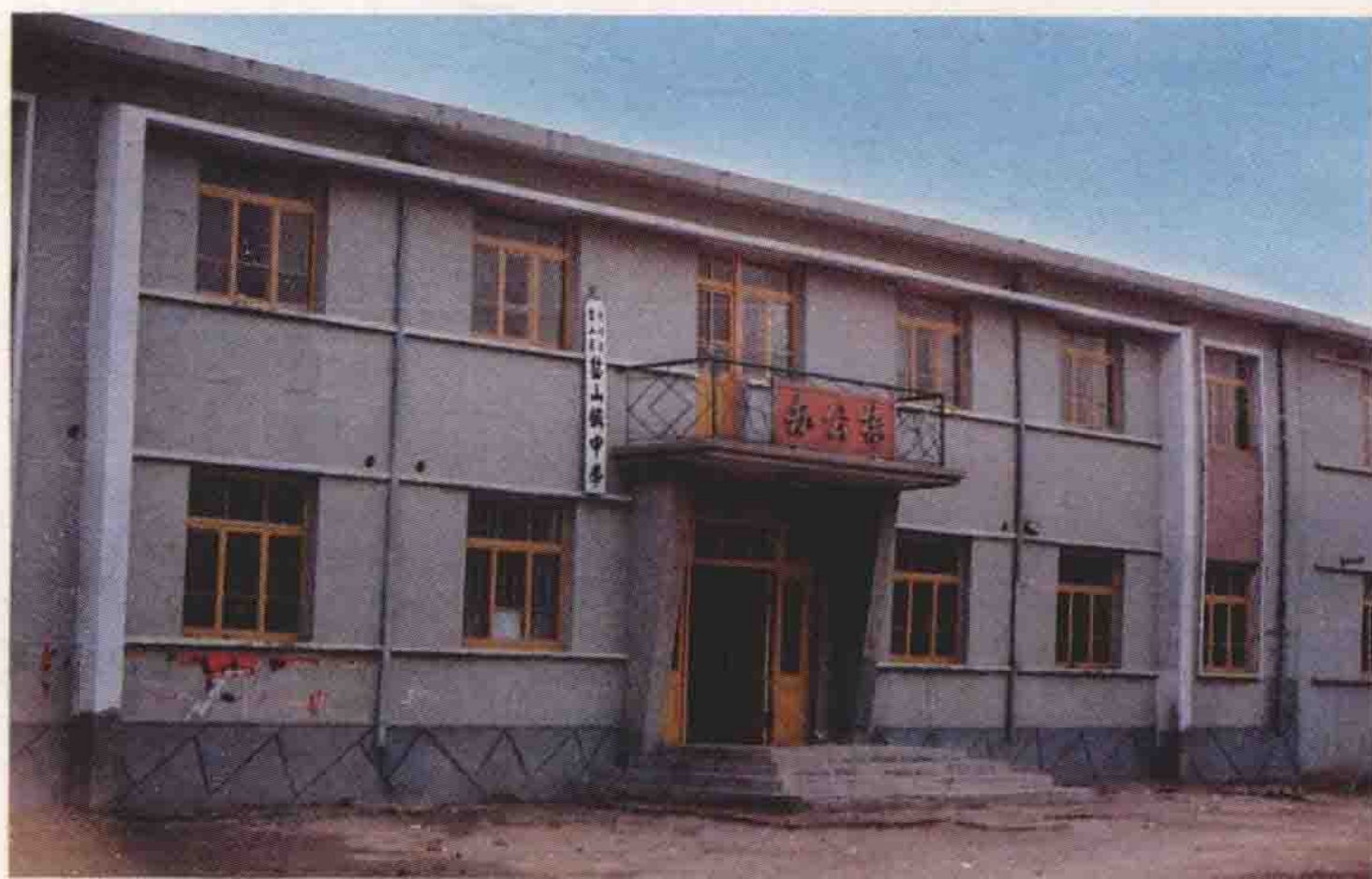
盐山县教育史 上第一栋楼房—— 盐山镇中教师办公 楼(1985年建)
