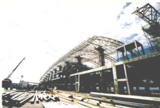
广东省机场集团公司工会积极开展白云国际机场扩建工程劳动竞赛。
