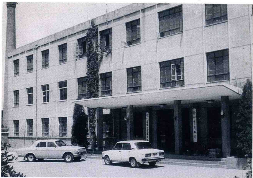
沧州市总工会办公楼(1982 年建)
