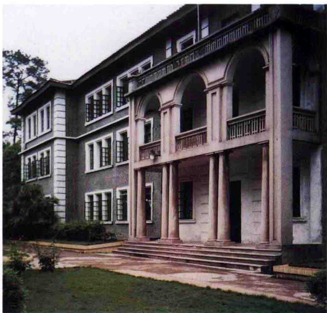
▲ 梧州校址教学楼
